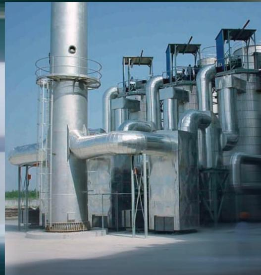
Wärmetauscher, Typ: LV-A/L
